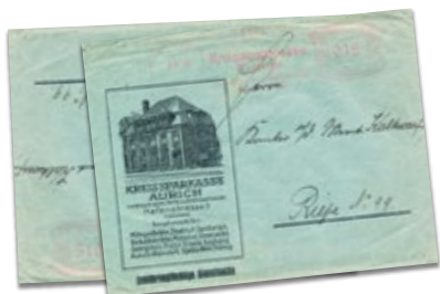
Briefkopf der Sparkasse Aurich mit einer Ansicht des Neubaus von 1913.
